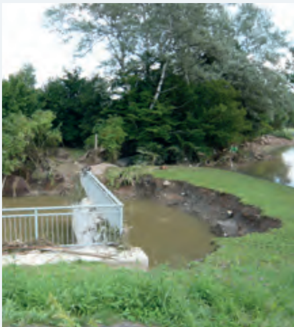
Abbildung 9-18: Ostritz, Kolk am Sielbauwerk (Foto: LTV)
