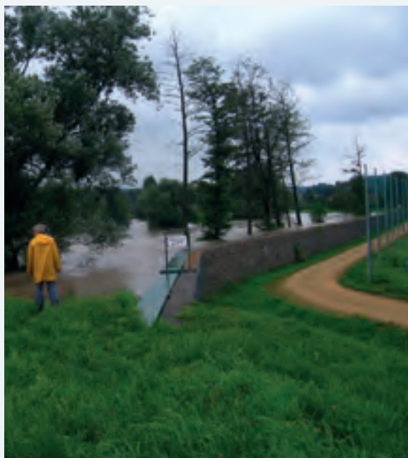
Abbildung 9-9: Kontrolle der Hochwasserschutzanlagen am 07.08.2010, nachmittags (Foto: LDS)
