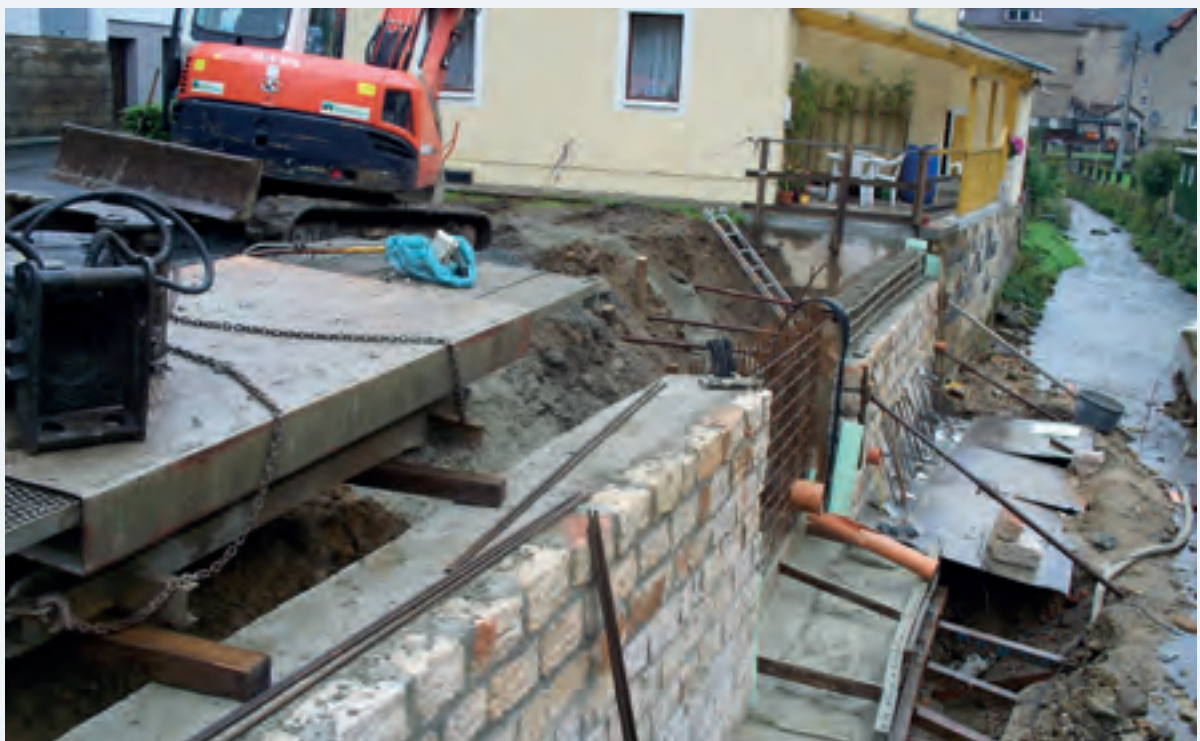
Abbildung 9-80: Endgültige Hochwasserschadensbeseitigung Sommer 2012 (Foto: Landesdirektion Sachsen)
