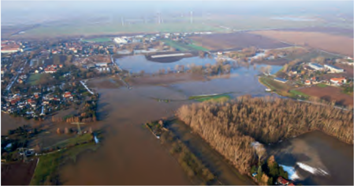
Abbildung 5-5: Überschwemmungen im Bereich Pegau am 10.01.2011 (Foto: LTV)
