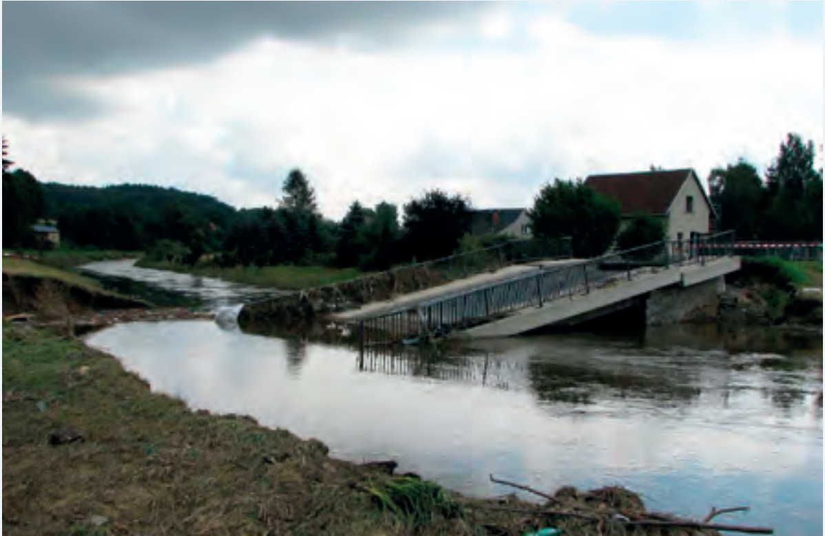
Abbildung 9-48: Zerstörte Brücke (Foto: Hr. Baldauf)
