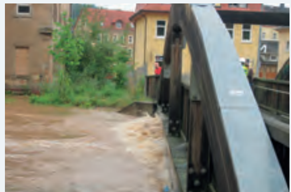
Abbildung 9-60: Einstau Brücke Hönickasteg (Foto: LTV)
