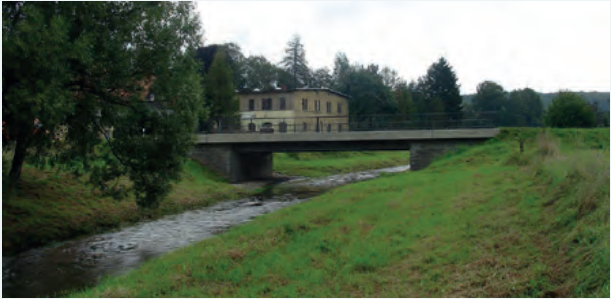
Abbildung 9-43: Vorhandenes Brückenbauwerk bis August 2010 (Foto: SBA Bautzen)
