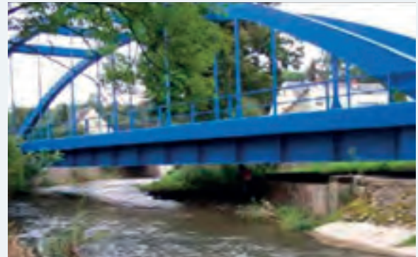
Eisenbahnbrücke „Blaues Wunder“
