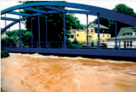
Abbildung 9-57: Einstau und Überströmen der Eisenbahnbrücke „Blaues Wunder“ in Chemnitz-Harthau am 07.08.2010 innerhalb weniger Stunden (Foto: LTV)
