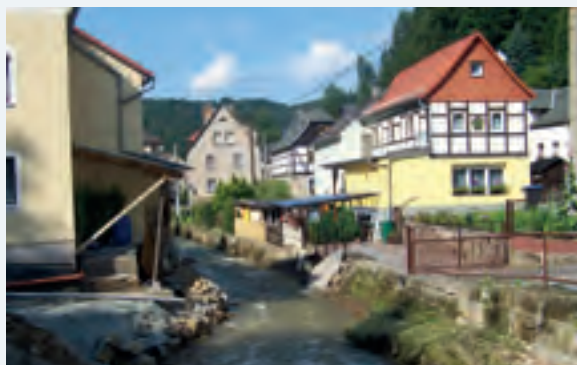
Abbildung 9-78: Nach dem Hochwasser des Krippenbachs, 10.08.2010 (Foto: LTV)
